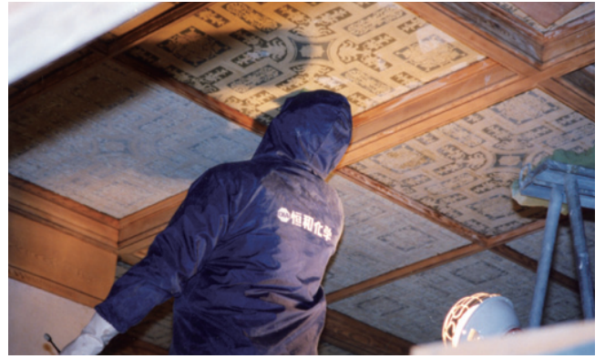
長官官舎食堂天井の金唐紙 修復作業
